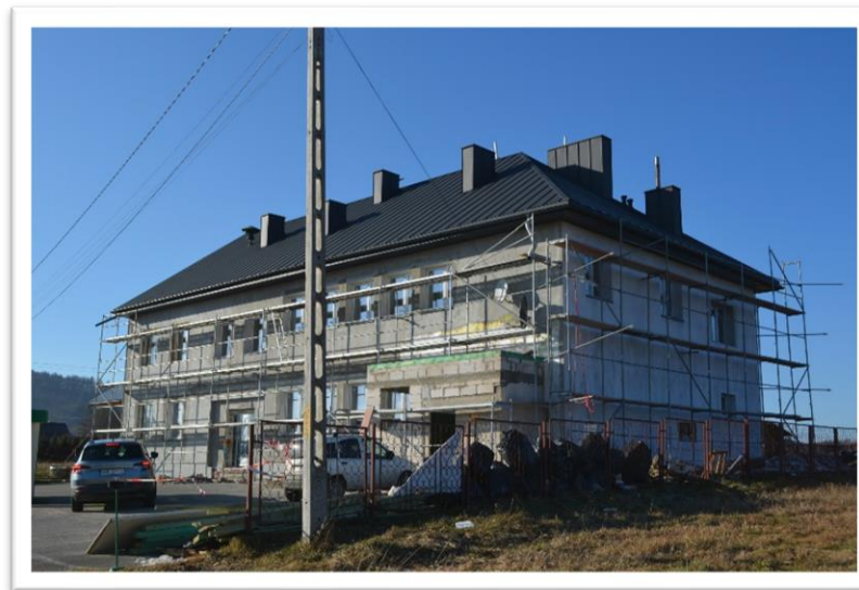
Rozpoczęte prace budowlane
